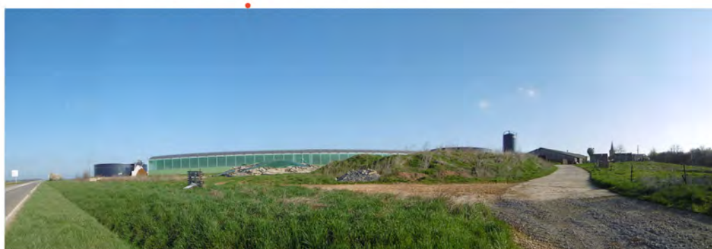
Bréhain-la-Ville | Unité de méthanisation
