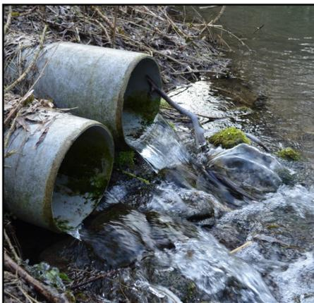
Leur remplacement par un lit filtrant réalisé à l'aide de graviers est une solution technique qui permet à la fois une meilleure reconnexion au cours d'eau et dans le même temps de filtrer l'eau en provenance de l'étang, ce qui laisse augurer une amélioration de la qualité de l'eau.
