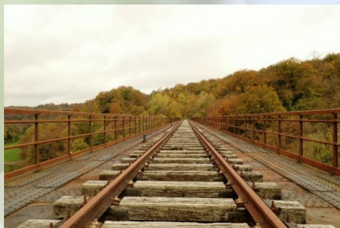
Viaduc de Serrouville
