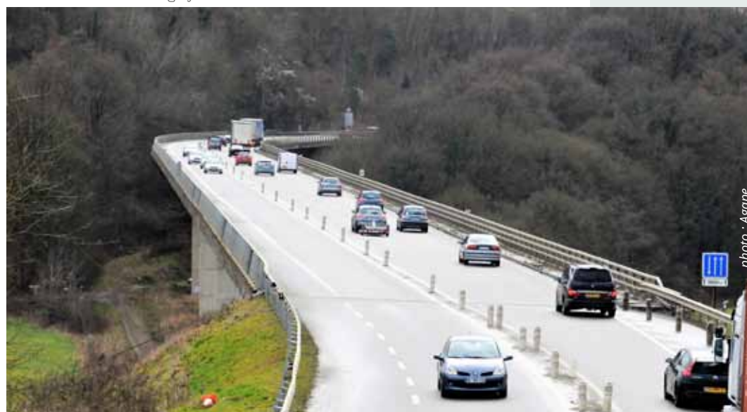
Contournement de Longwy : Viaduc de Piedmont - Mont-Saint-Martin
