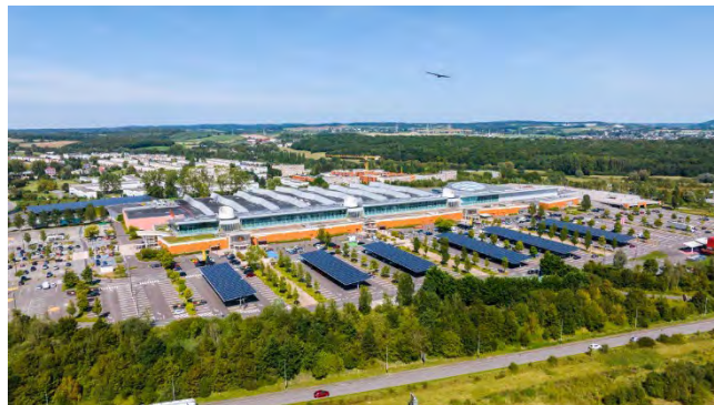
Ombrières sur le parking d'Auchan Pôle Europe à Mont-Saint-Martin (photo : ©Dark M Studio)
