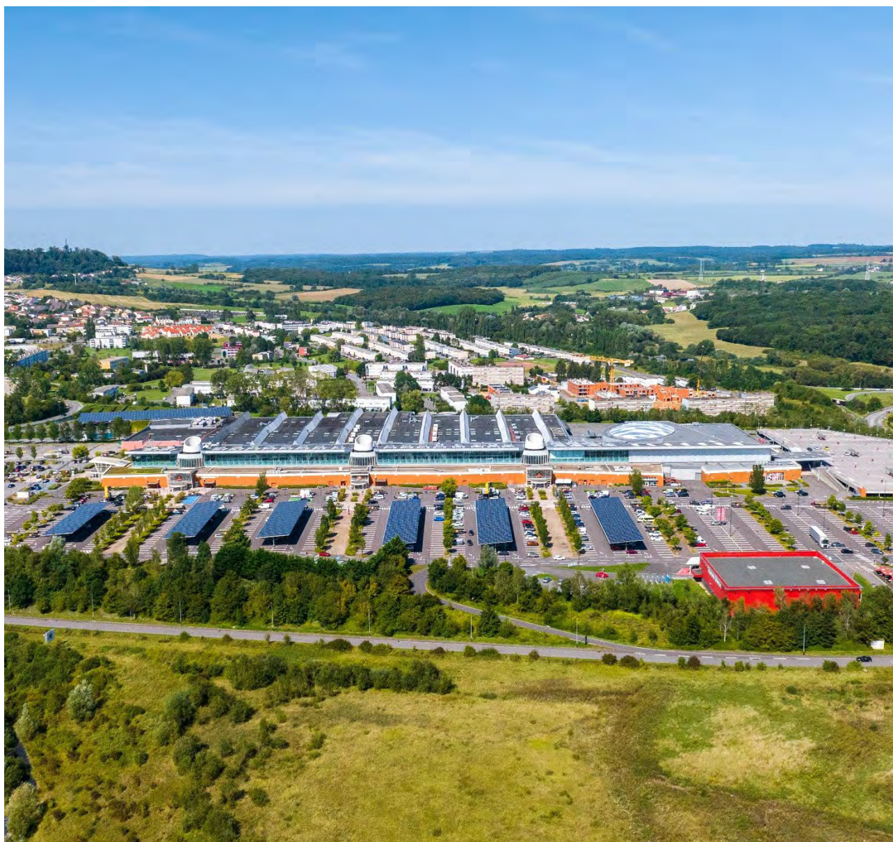
Ombrières sur le parking d'Auchan Pôle Europe à Mont-Saint-Martin (photo : ©Dark M Studio)
