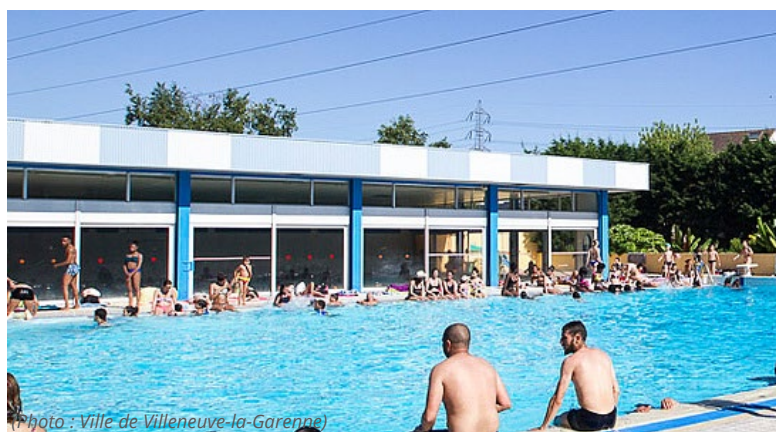
Piscine de Villeneuve-la-Garenne (92) avant rénovation
